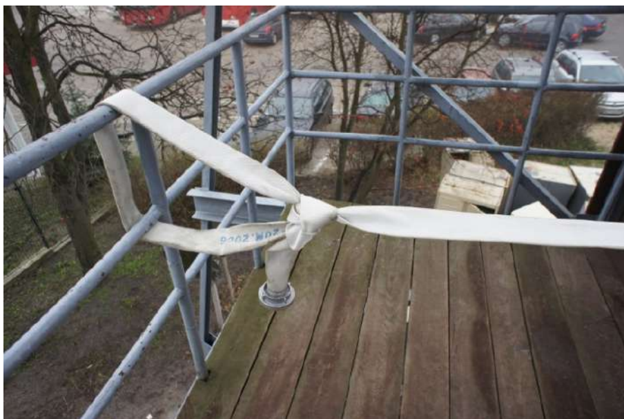
Rys. 32). Stanowisko do samoratowania z WP 52
